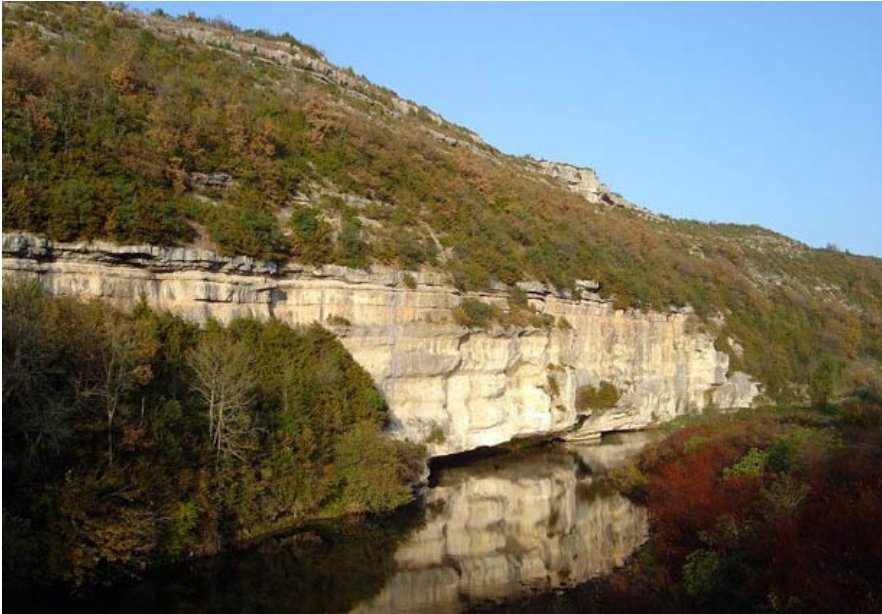
Les Calcaires de Castres et de Labruguière, à l'Ouest de Caucalières. L'affleurement en falaise domine le Thoré.
