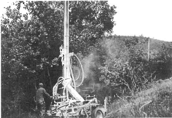
Photographie 4 : Forage de reconnaissance et emplacement du puits d'Amiel. Cliché Claude Bou.
