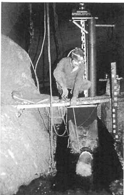
Photographie 9 : Aménagement du déversoir LM1 du siphon d'Amiel (limnigraphe et filet à plancton). Cliché Claude Bou.
