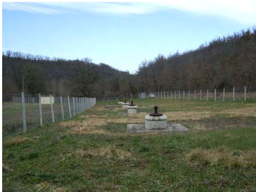
Fig. 27. Le périmètre de protection immédiate du champ captant de Terrailac
